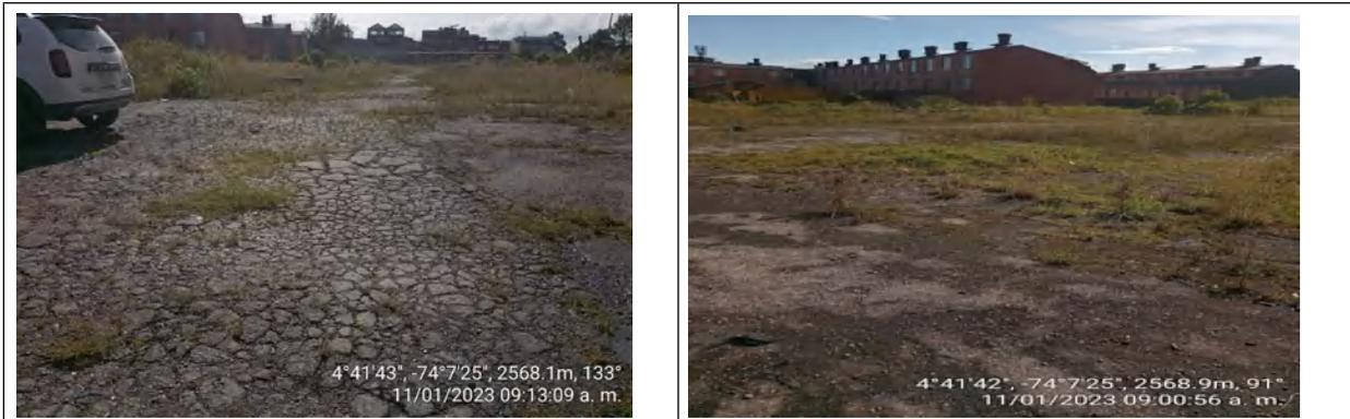
**Fotografía 1 y 2. Placa asfáltica fracturada**
